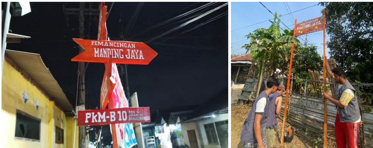
Gambar 4. Proses Pemasangan Signboard
